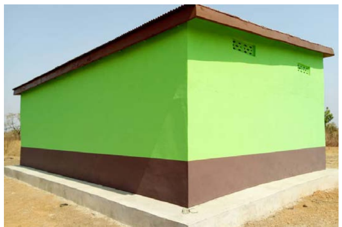
Entrepôt construit avec des blocs de gravier à Fuu, au Ghana
